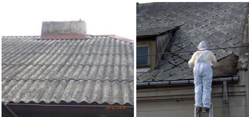
Ryc. 13. Rodzaje wyrobów zawierających azbest. Po lewej - płyty dachowe faliste (W02), po prawej - płyty azbestowo - cementowe typu „karo” (W01)
