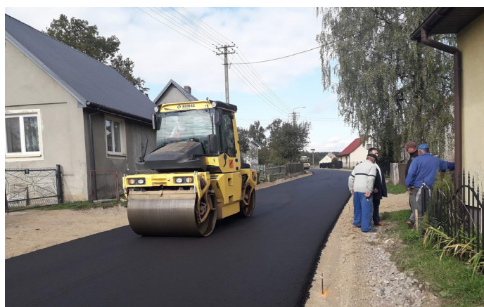
Przebudowa drogi w Kossakach
