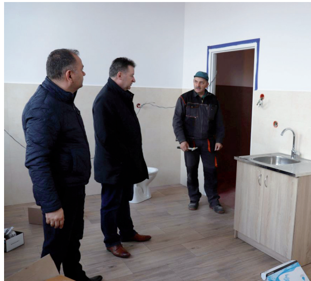
Remont świetlicy w Filipkach Dużych
