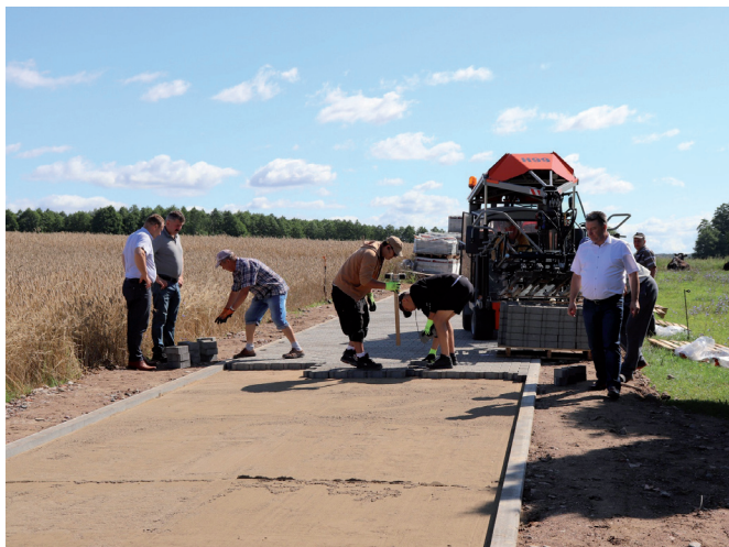
Budowa drogi z kostki brukowej w Pachuczynie
