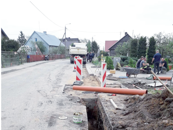
Budowa odwodnienia drogi w Borkowie
