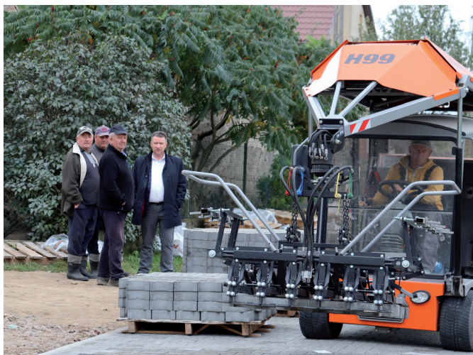
Budowa drogi z kostki brukowej we Wścieklicach
