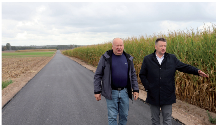
Przebudowa drogi w Janowie
