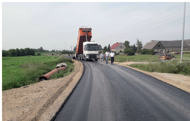
Przebudowa drogi w Truszkach Zalesiu
