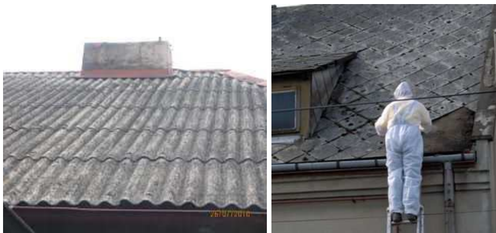
Ryc. 13. Rodzaje wyrobów zawierających azbest. Po lewej - płyty dachowe faliste (W02), po prawej - płyty azbestowo - cementowe typu „karo” (W01) Źródło: www.wizja24.pl , www.zgpd7.pl .
