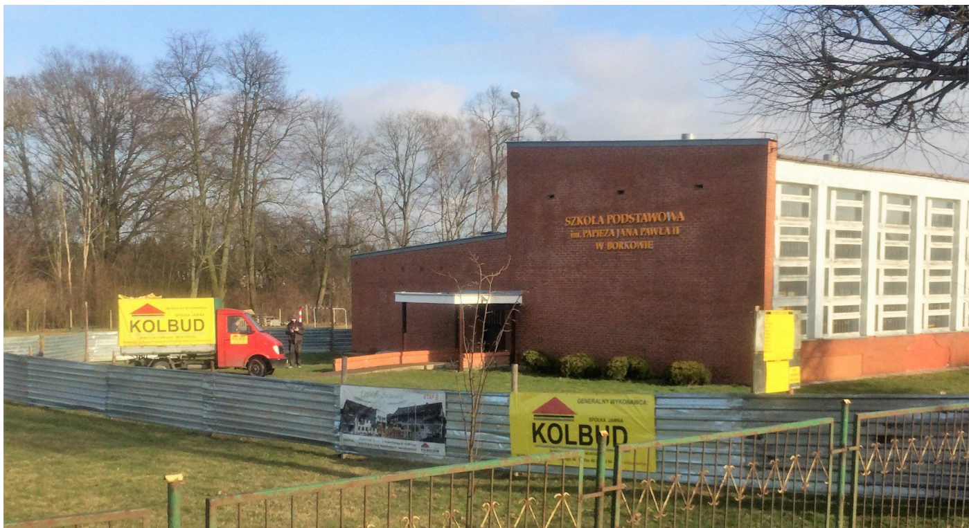
Rozpoczęcie prac przy rozbudowie i przebudowie szkoły w Borkowie
