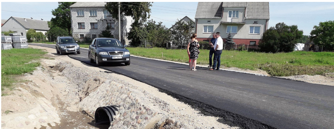
Modernizacja drogi w Tyszkach - Wądołowo
