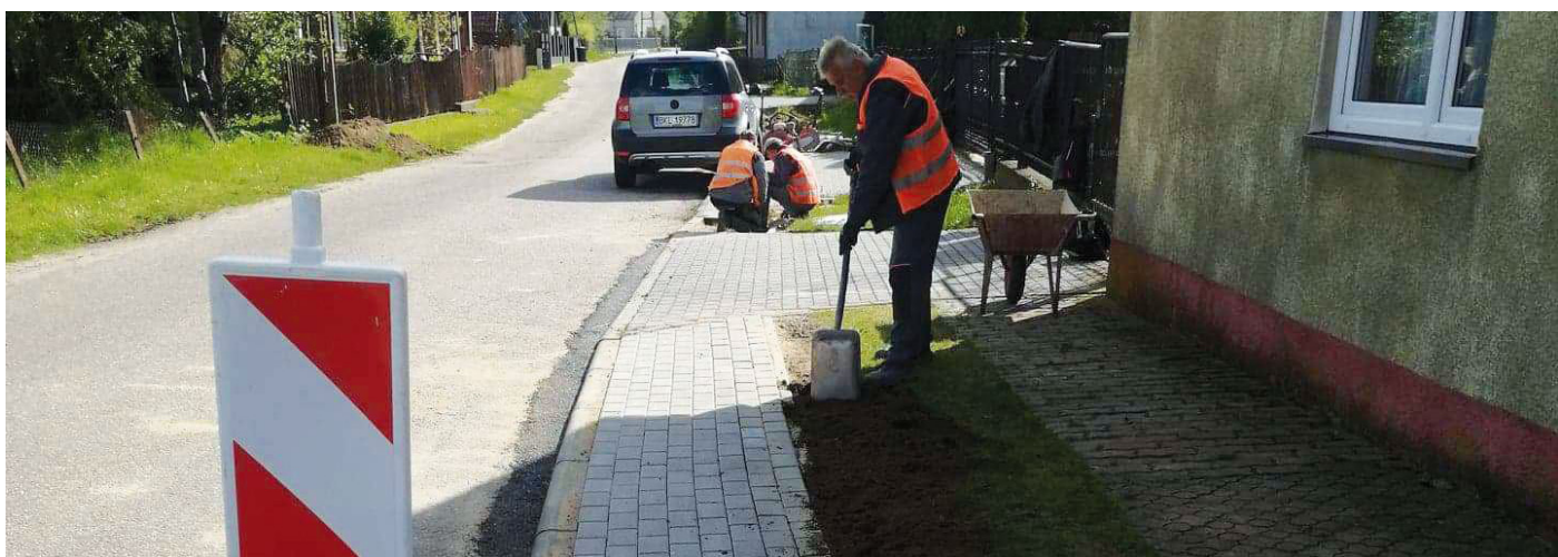
Utwardzanie poboczy drogi w Czerwonym
