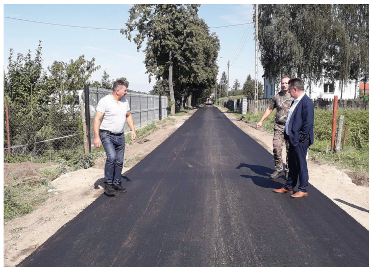
Modernizacja drogi w Starym Gromadzynie
