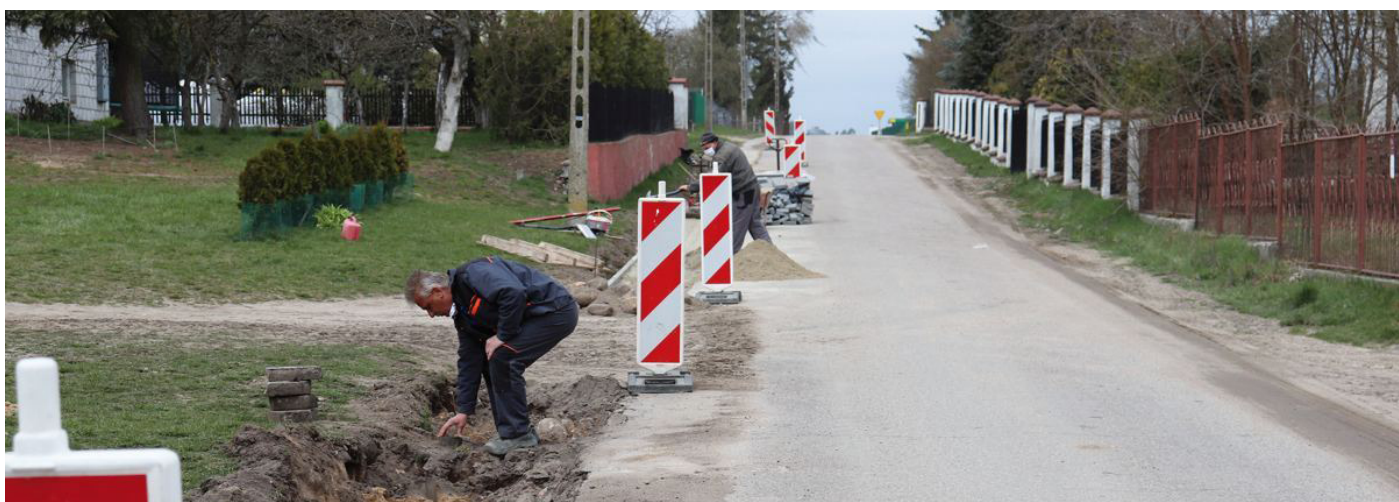
Poszerzanie poboczy drogi gminnej w Tyszkach - Łabno
