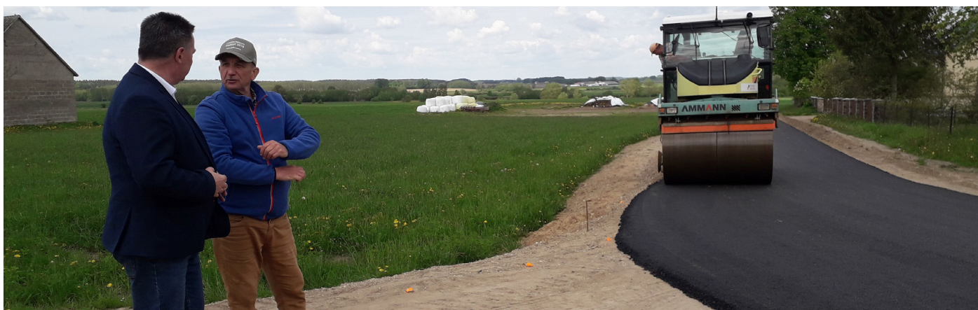
Droga gminna w Kumelsku, na której przebudowę Gmina Kolno pozyskała środki w 2020 roku, w maju 2021 r. już była w trakcie modernizacji
