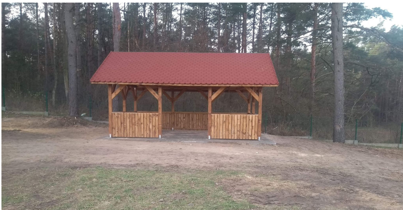
Utwarczanie miejsca pod altanę na placu gminnym w Rupinie.
