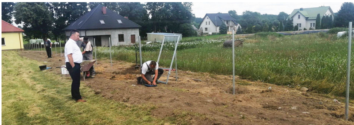
Budowa ogrodzenia placu w Bialikach
