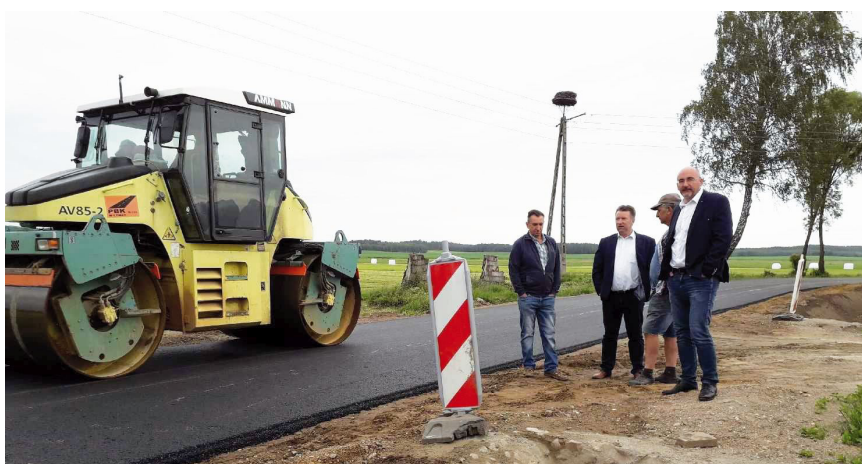
Modernizacja drogi w Brzózkach
