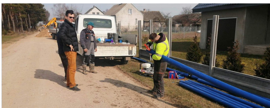
W 2020 r. poradcownicy Referatu Gospodarki Komunalnej Urzędu Gminy Kolno po raz pierwszy wykonali rozbudowę sieci wodociągowej. Na zdjęciu realizacja zadania.
