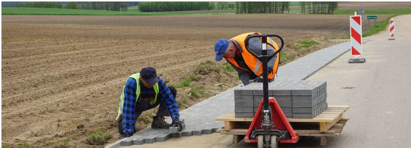
Utwardzanie poboczy drogi gminnej w miejscowości Kielcze Kopki
