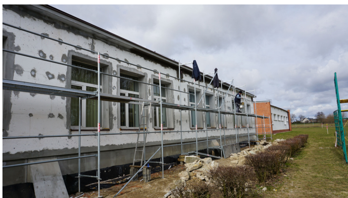
Docieplenie budynku szkoły w Borkowie
