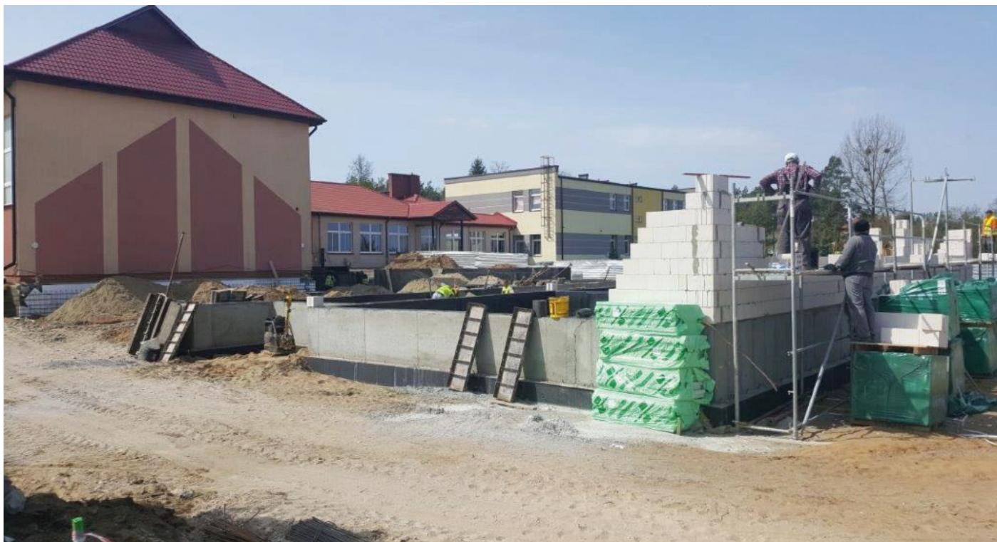
Rozbudowa Szkoły Podstawowej w Lachowie
