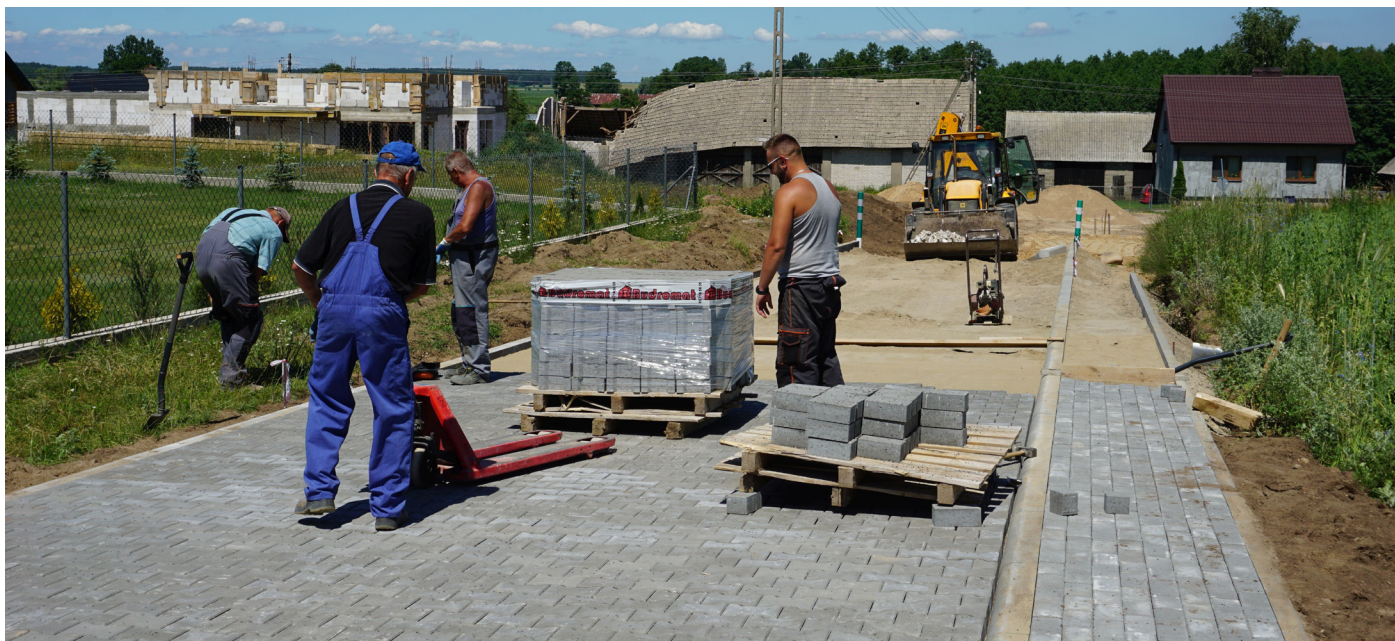
Budowa drogi z kostki brukowej w miejscowości Bialiki
