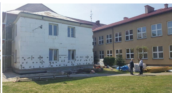
W 2019 r. zakończono II etap termomodernizacji budynku szkoły w Zabieliu
