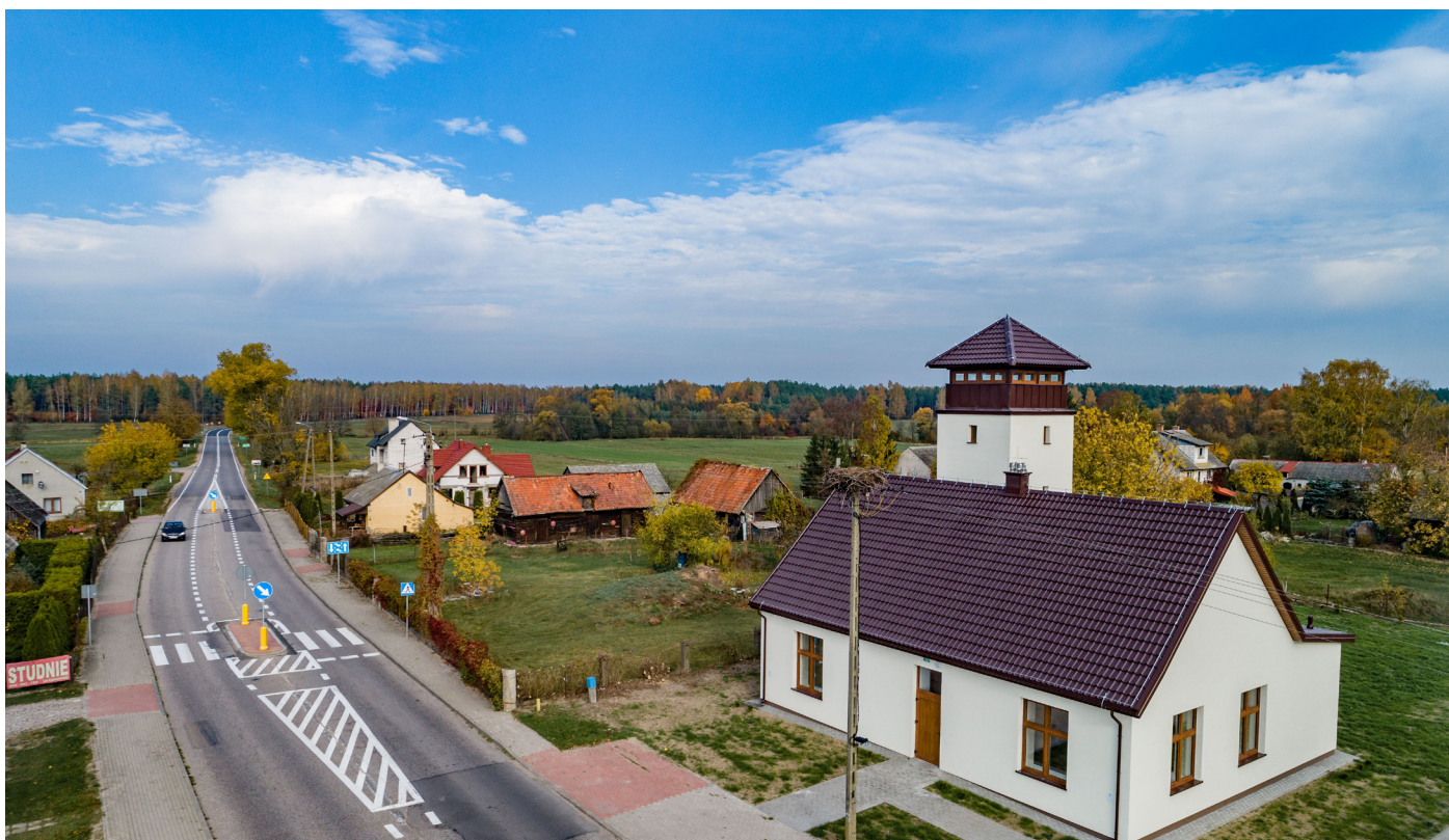
Budynek w Wincencie po przebudowie służy lokalnej społeczności fot. Maciej Nowakowski Fundacja Zapomniane Podlasie
