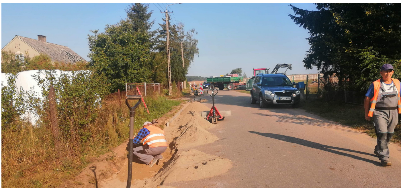
Utwardzanie poboczy w miejscowości Tyszki Łabno
