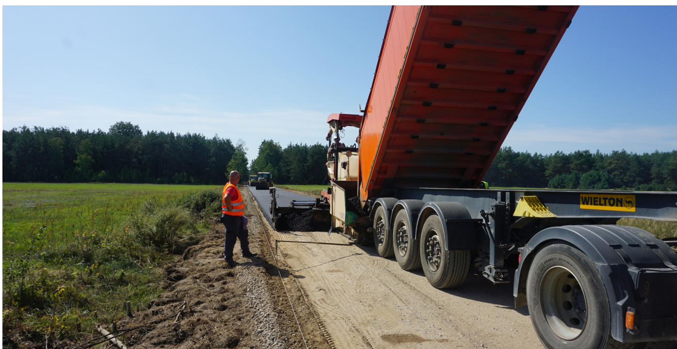
Przebudowa drogi powiatowej Janowo - Łosewo - Niksowizna
