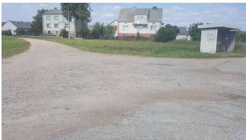
Droga w Tyszkach Wądołowo przed remontem
