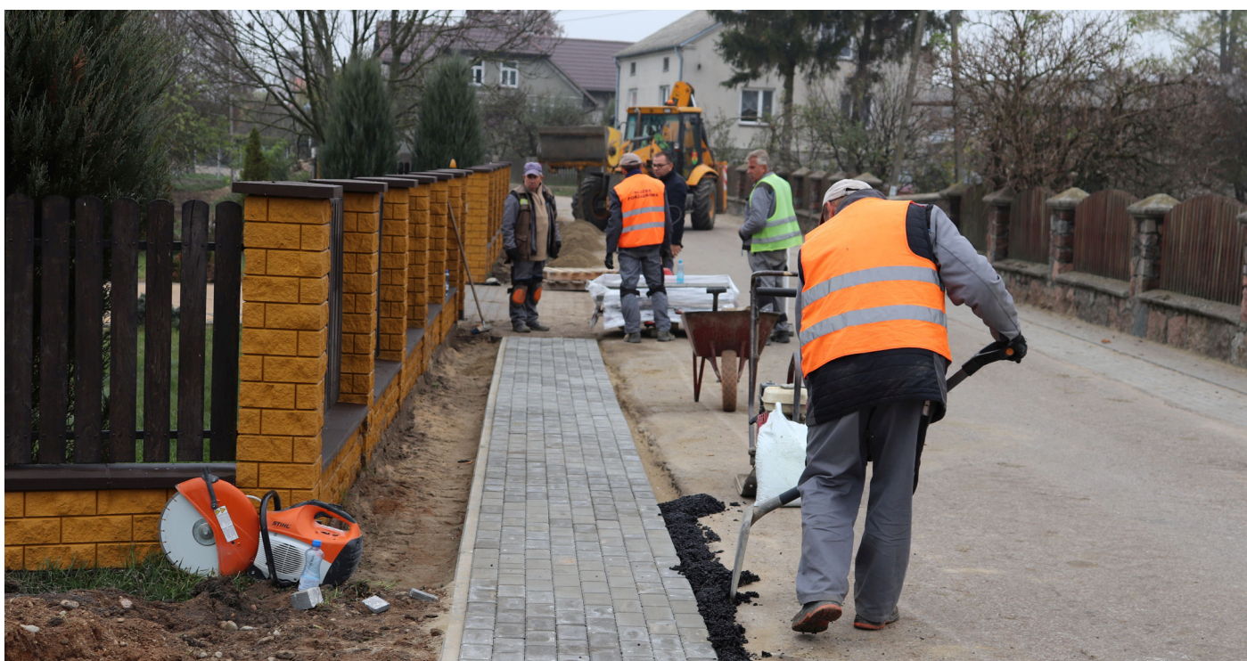
Utwardzanie poboczy w miejscowości Zabiele Przymiarki
